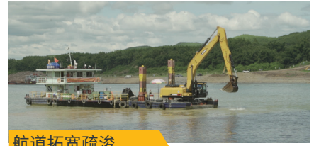
航道拓宽疏浚
