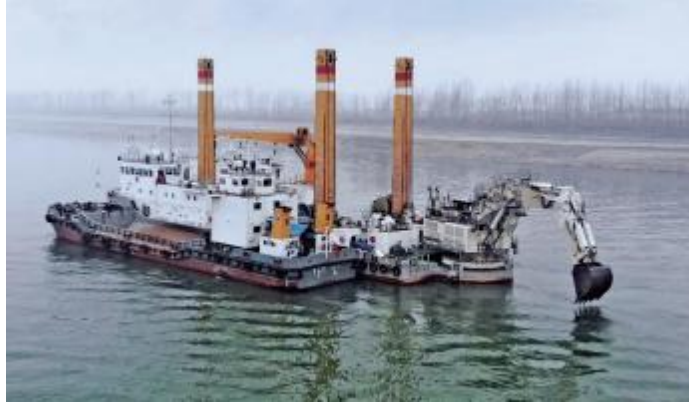
常见的航道疏浚工程场景作业照片
