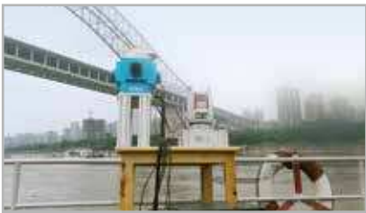
朝天门大桥测量
