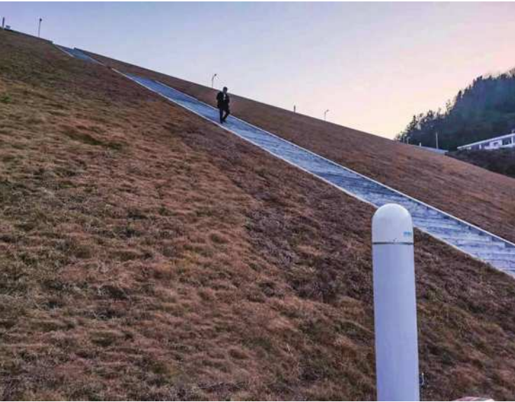
▲安装在坝体上的中海达水库大坝安全监测系统
