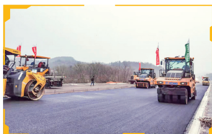
德州至上饶国家高速公路合肥至枞阳段
